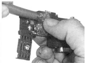
11. Nach dem Abisolieren der PB FC Leitung kann diese direkt im FastConnect Stecker montiert werden
