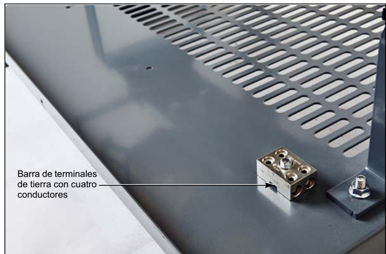
Figura 24: Barra de terminales de tierra con cuatro conductores
